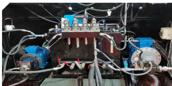
BANCO PARA PRUEBAS DE BOMBAS HIDRÁULICAS
