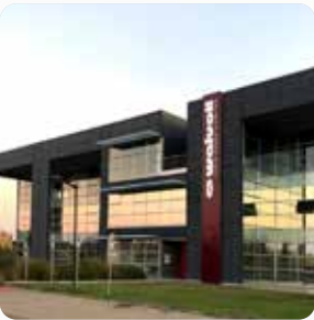
Galtech Site Cavriago (RE) • Italy
